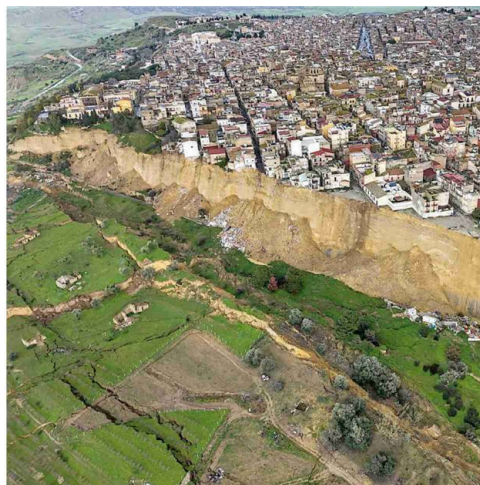
La frana di Niscemi
