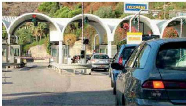
Il ministero minaccia di "chiudere" la A18 e la A20 e di avviare la revoca della concessione al Cas
