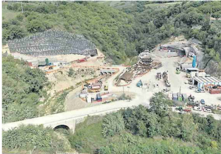
I CANTIERI Un'immagine dei lavori dell'Alta velocità Napoli-Bari: la tratta prevede un investimento complessivo di 6,3 miliardi di euro
