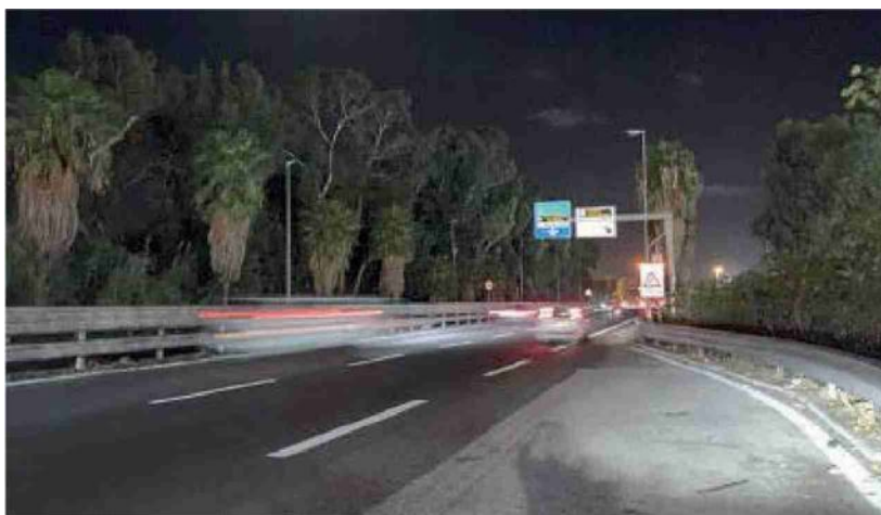
Uno dei tratti dell'arteria (S.p. 70/I) che sarà oggetto di lavori da oggi
