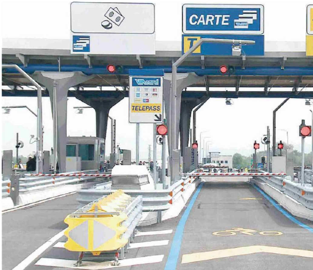
Caselli autostradali Pronto il pedaggio anche sulla Siracusa-Gela
