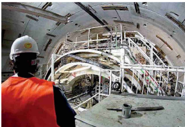
Nell'immagine la macchina Tbm all'opera per gli scavi della nuova tratta
