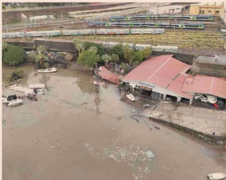
Devastazione. La marina di Porto Rossi a Catania dopo il passaggio di Harry
