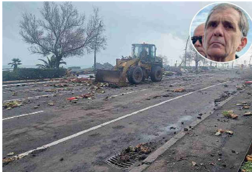
Un escavatore in azione lungo viale Riuggero di Lauria. In alto il sindaco
