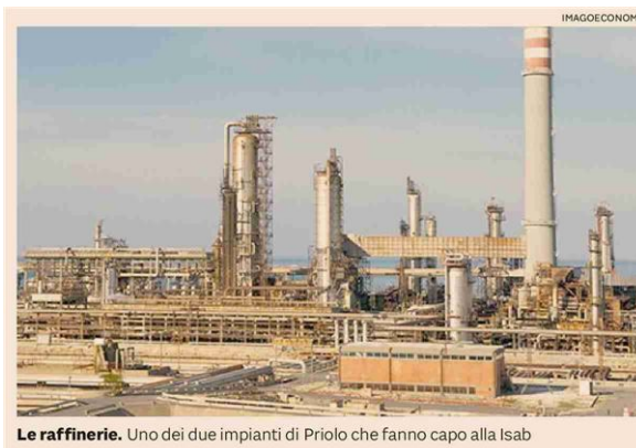
Le raffinerie. Uno dei due impianti di Priolo che fanno capo alla Isab
