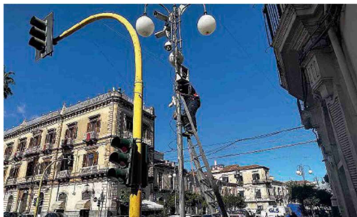
Il montaggio delle telecamere di videosorveglianza in piazza Duomo a Giarre
