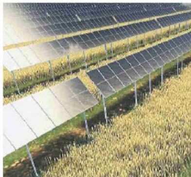
Sopra: pannelli solari agrivoltaici In alto a destra Rocco Minissale
