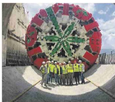
Una talpa Tbm di Webuild in Sicilia
