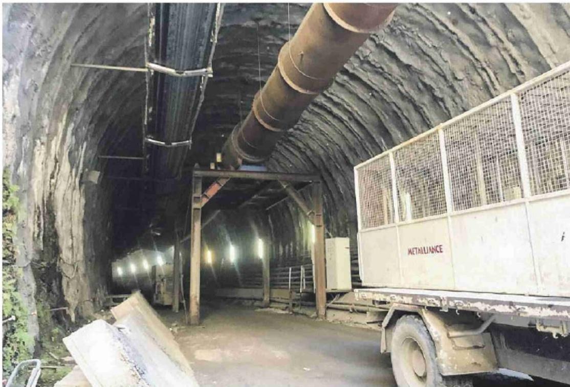
La galleria finora scavata e gli anelli montati che servono a riportare in superficie il materiale rimosso
