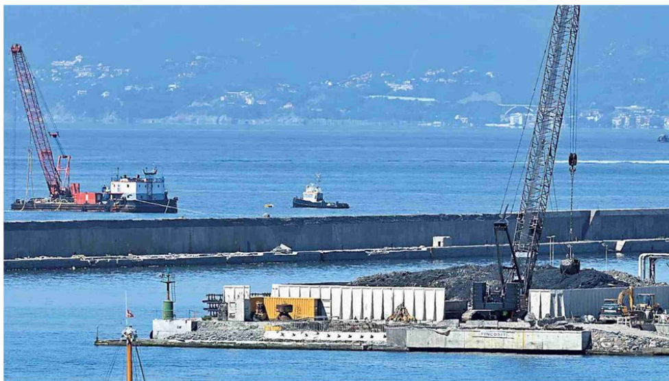
▲ Il cantiere Lo scavo della diga di Genova
