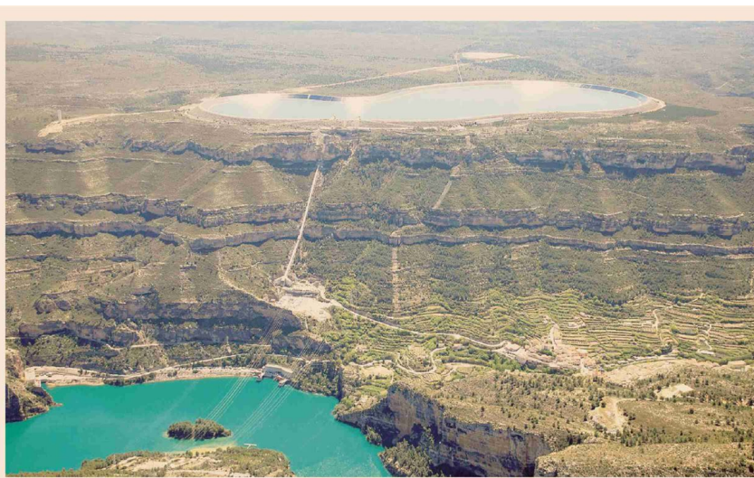
Cortes La Muela. L'impianto di Iberdrola è la più grande centrale idroelettrica a ciclo chiuso d'Europa, con una potenza di 1.8 gigawatt, quasi equivalente a due centrali nucleari
