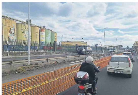
I lavori in corso di via Tempio
