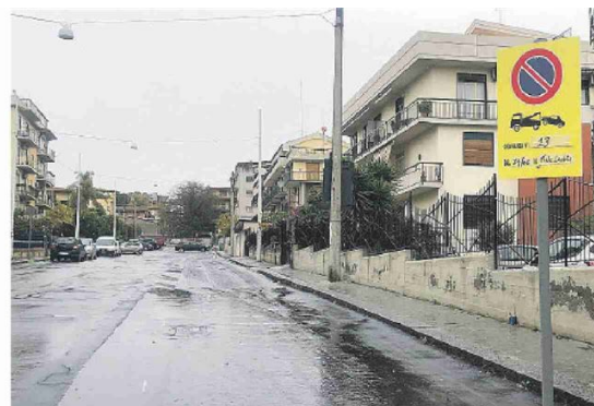
Il tratto di via Bergamo scarificato e su cui realizzerà la pista
