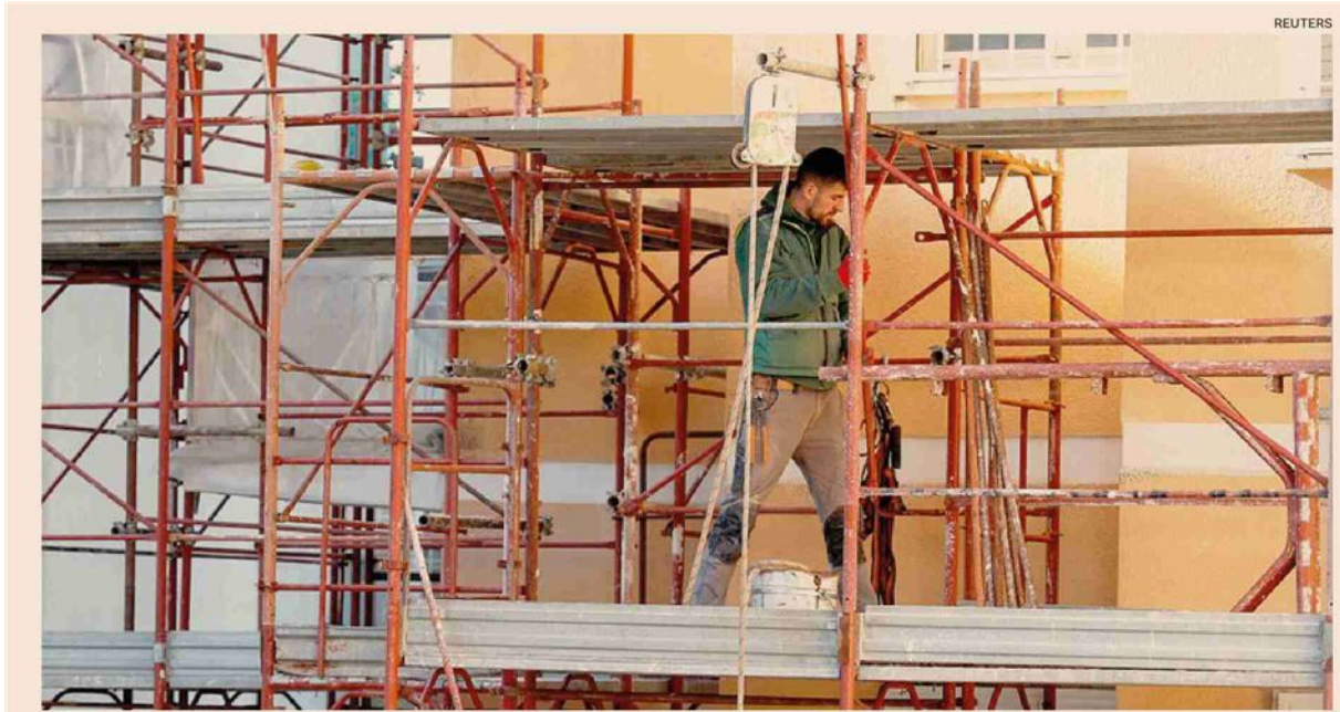
I ritardatari. I condomini che non hanno finito i lavori nel 2023 hanno il superbonus al 70% nel 2024 e al 65% nel 2025
