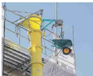
Nuovi lavori con il Superbonus
