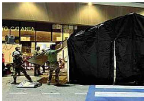
Al check-in Le strutture climatizzate installate per estendere l'operatività dell'aeroporto di Catania (Ansa)
