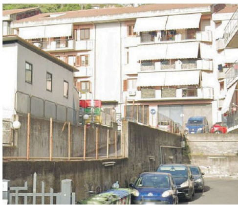
La palazzina di Aci San Filippo in cui si è registrato l'intervento dei pompieri
