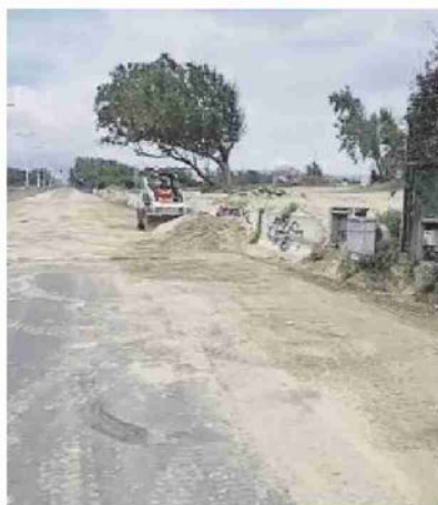
Rimozione sabbia al viale Kennedy
