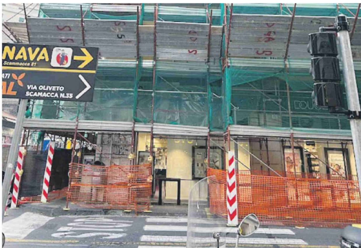
Un'attività all'incrocio fra la via D'Annunzio e la via Oliveto Scammacca "nascosta" da un cantiere
