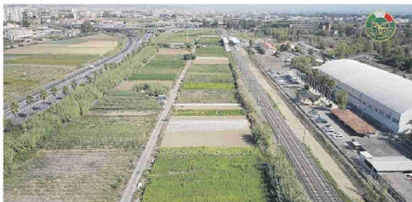
A sinistra immagine ripresa grazie al sorvolo del drone della guardia forestale sui canali di servizio del Torrente Forcile, stazione aeroporto Fontanarossa Sopra il sopralluogo al Forcile
