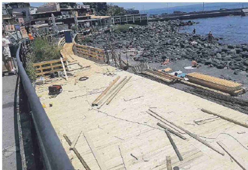
La passerella a li Cuti, il cantiere sotto p. Europa e la scaletta sulla spiaggia
