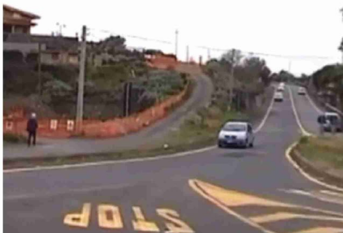
Gli operai sono al lavoro alla periferia di Adrano
