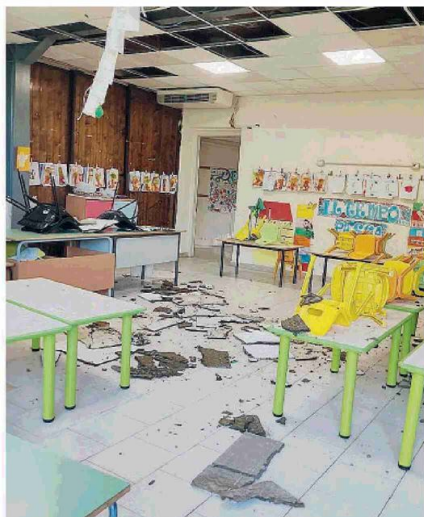
Nelle due foto, altrettanti esempi di infiltrazioni di acqua nelle classi dell'ex IV circolo didattico
