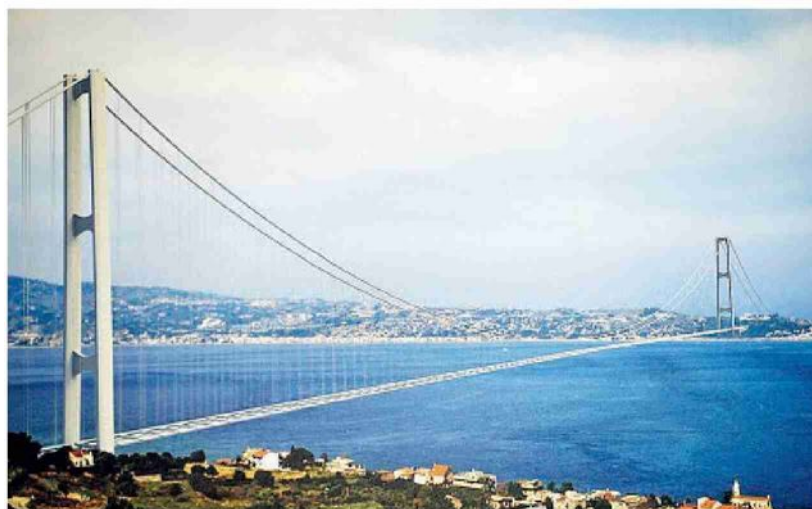
Per la Commissione europea il Ponte sullo Stretto va realizzato
