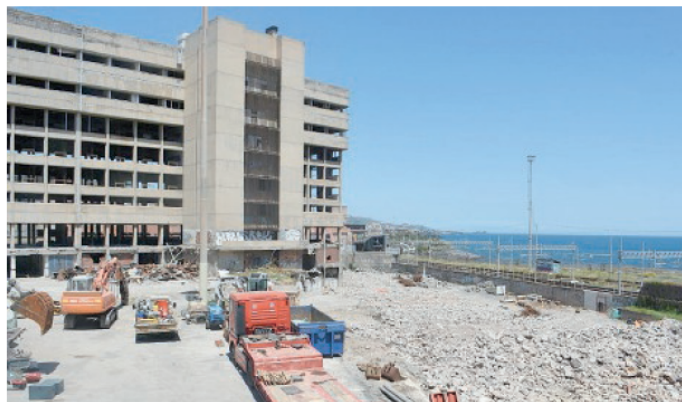
I lavori in corso per la demolizione dell'ex palazzo delle poste (Foto Zappalà)
