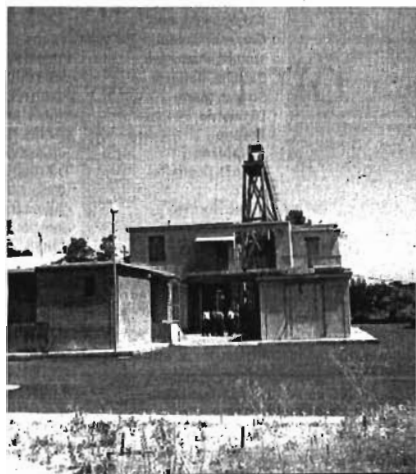
Il pozzo di Ciapparazzo a Bronte
