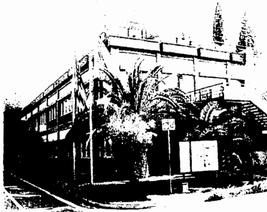
IL SITO DELLA WYETH LEDERLE, ALLA ZONA INDUSTRIALE
